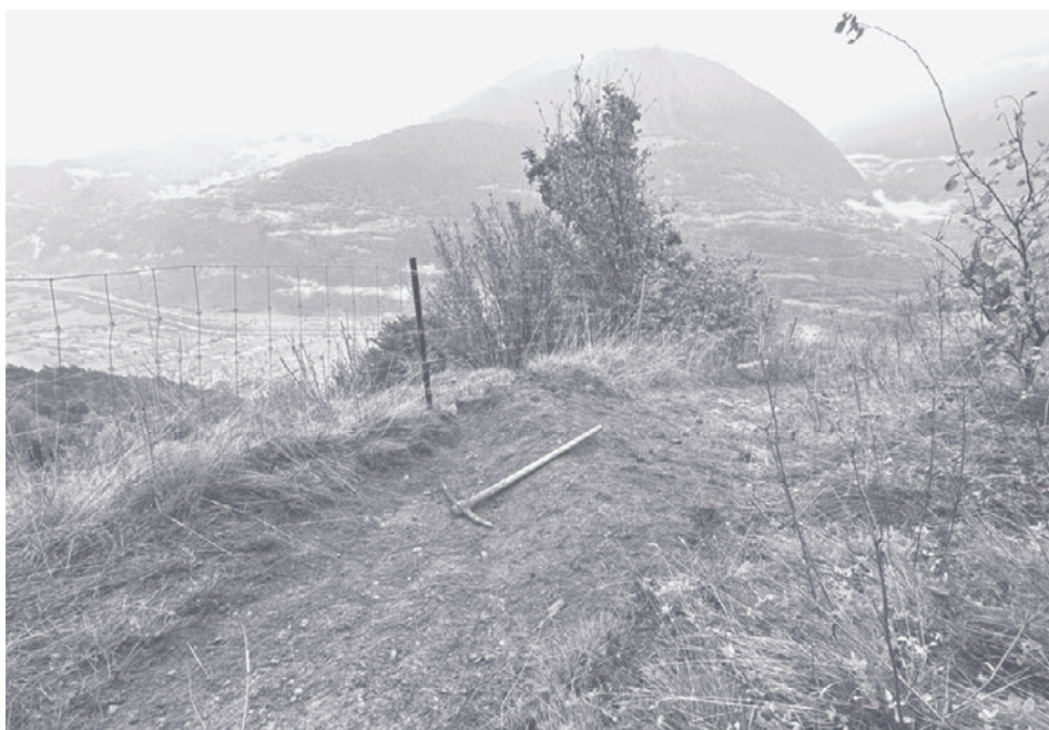
Fertiggestellte Entwässerungsmulde; die eingebauten Steine sind wieder mit Erdmaterial überdeckt.
